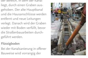
sogenannte Flüssigboden eingesetzt. Dieses spezielle Verfahren der Rohrgrabenverfüllung vermeidet Erschütterungen durch schweres Verdichtungsgerät. So wird die Bebauung geschützt und Lärm minimiert. Beim Flüssigboden wird der vorhandene Boden durch ein bestimmtes Verfahren in zeitweise fließfähigen Zustand versetzt und anschließend wiederverwendet. Nach Einbau im Rohrgraben erhärtet er kontrolliert. so dass die Bodeneigenschaften des umgebenden Bodens wieder erreicht werden.
