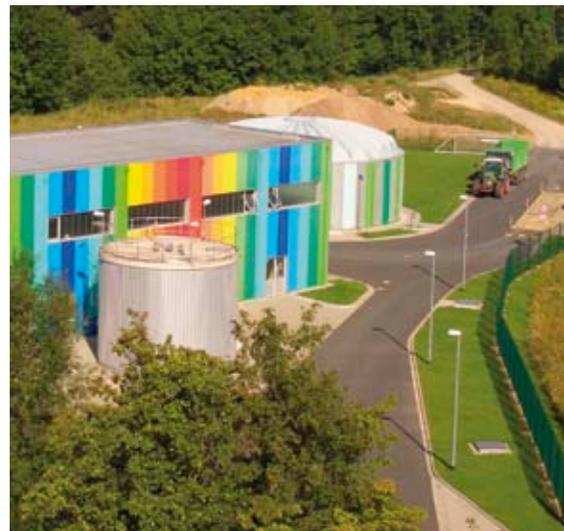
Nach der Entwässerung wird der Klärschlamm in einem Silo zwischen gespeichert. Dort wird der Klärschlamm täglich von einem beauftragten, externen Verwerter abgeholt und Landwirten in der Region zur landwirtschaftlichen Verwertung überlassen.
