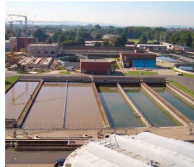
Das Abwasser wird dann in die Vorklärbecken gepumpt. Hier setzen sich ungelöste Feinteile (Schlammteilchen) ab. Diese werden von Bodenräumern zu Schlammtrichtern geschoben und von dort als Primärschlamm in die Faulbehälter gepumpt. Durch diese mechanischen Reinigungsstufen wird rund ein Drittel der Verschmutzung aus dem Abwasser entfernt.
