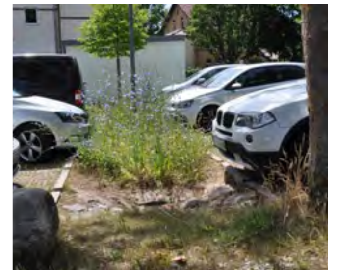
Abbildung 38: Muldenversickerung auf einem Parkplatz (© GEB)
