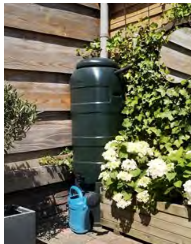
Abbildung 43: Speicherung von Regenwasser im Garten mit einer Regentonne. (© IstockPhoto/Patrick Herzberg)
