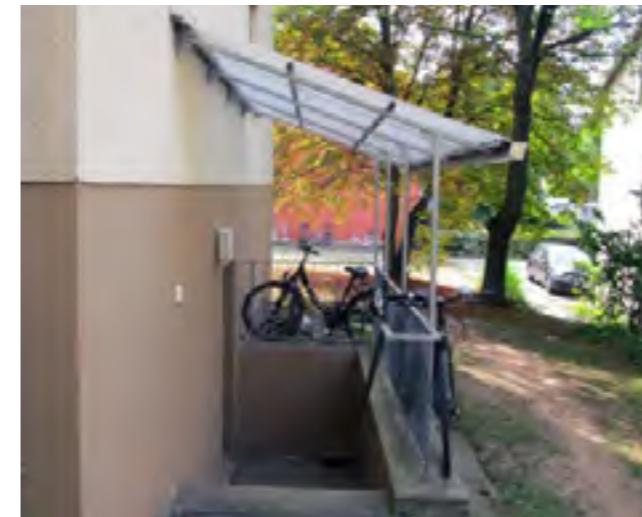
Abbildung 26: Überdachter Kellerabgang. (© GEB)
