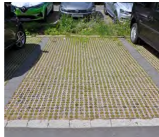
Abbildung 37: Rasengittersteine als wasserdurchlässiger Bodenbelag auf einem Parkplatz (© GEB)
