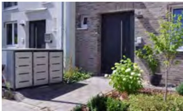
Abbildung 23: Schräge vor einer Eingangstür. (© GEB)
